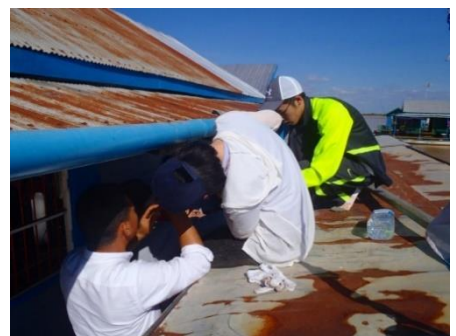
雨どいの設置
