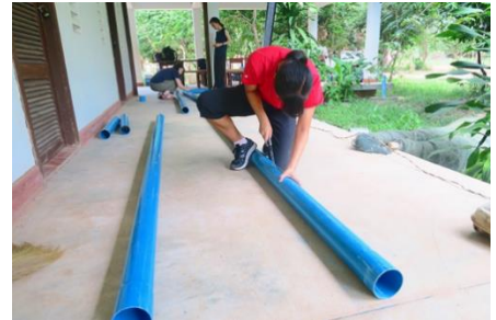
現地で購入した塩ビ管を加工
